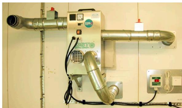
**Un appareil DR-010B avec hygrostat EH4 de DST contrôle l'humidité dans un poste de surpression**
