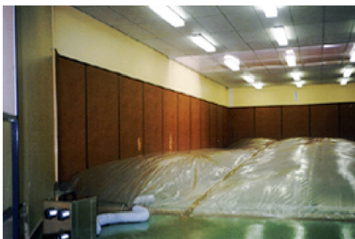
Dégats des Eaux - Séchage Chapes
