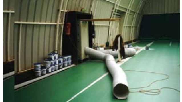
Séchage revêtement de sol
