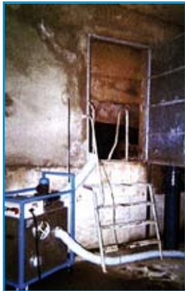
Rénovation de caves
