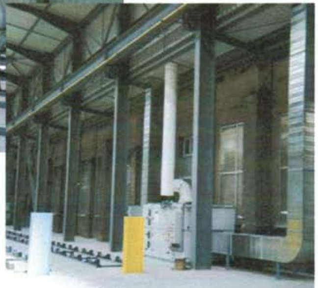
Centrale de traitement d'air CBK d'une aire de stockage
